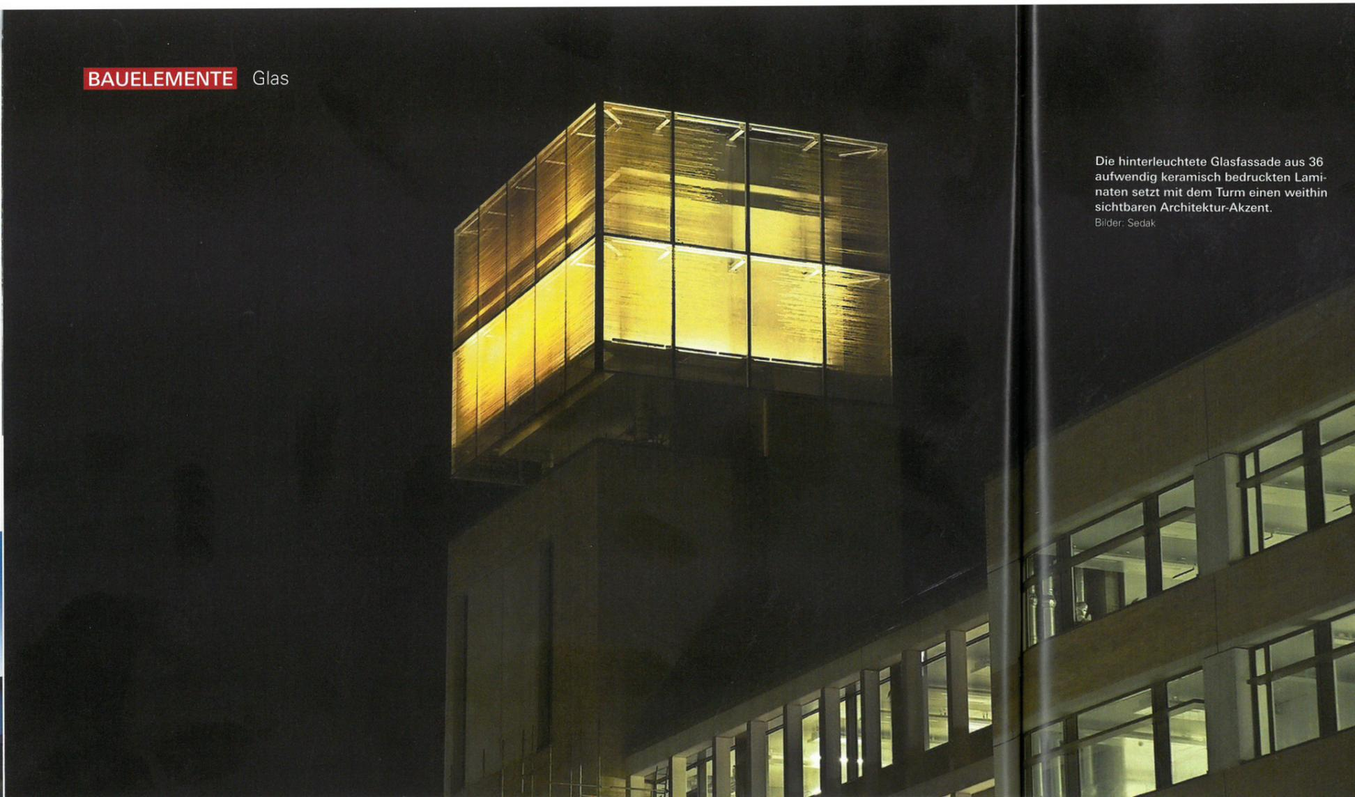
Die hinterleuchtete Glasfassade aus 36 aufwendig keramisch bedruckten Laminaten setzt mit dem Turm einen weithin sichtbaren Architektur-Akzent.
