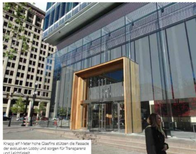
Holz in Glas. Eukalyptus ist ein relativ hartes Holz. Daher ist es für die Lamination gut geeignet. Fotos: Steel Encounters Inc., Salt Lake City, US
