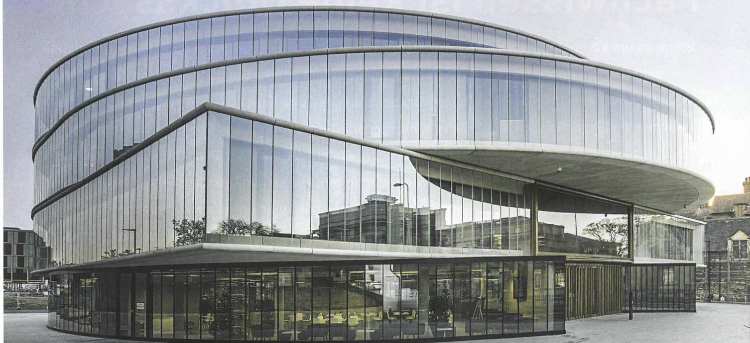
Realisiert wurde die Scheibe mit einer Größe von 10,7 x 3,2 Metern von dem deutschen Glasveredler sedak. Dieser fertigte im Auftrag von Waagner-Biro die zweifach-Isolierglasscheibe mit einer Fläche von rund 34 Quadratmetern und einem Gewicht von 3,5 Tonnen. Der Glasspezialist übernahm auch den Transport der übergroßen Glasscheibe.
