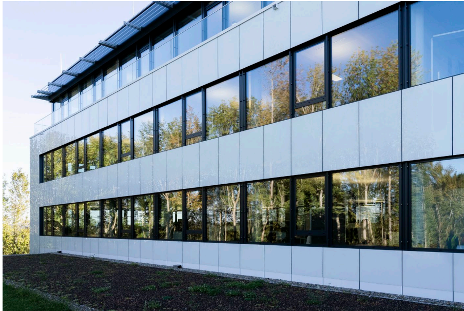
Bild: [24-03_02]: Der Wechsel zwischen vertikal verlegten sedak gsp -Paneelen und Fensterbändern erzeugt eine architektonisch-spannende Ästhetik.
