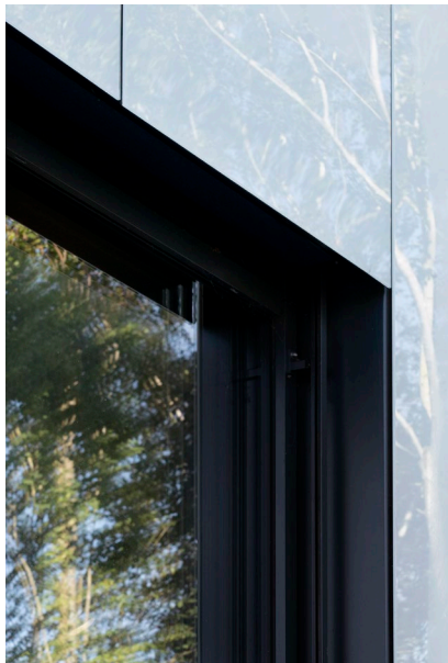
Bild: [24-03_03]: Eine überstehende Glasscheibe verdeckt das Raffstore-Paket..
