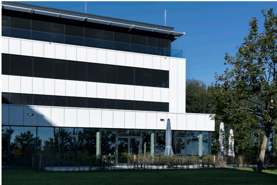
Bild: [24-03_01]: Die Fassade des Verwaltungsgebäudes der Molkerei A. Müller aus weißen sedak gsp -Elementen.
