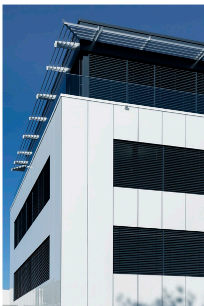
Bild: [24-03_04]: Um dem Gebäude einen besonderen gestalterischen Akzents Augenmerk zu verleihen, wurden an den Gebäudeecken sedak gsp -Elemente mit 12 Metern Länge installiert. Bild: ©sedak GmbH & Co. KG
